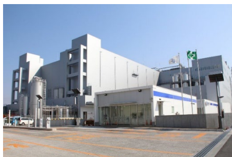
<海老名工場：外観>
