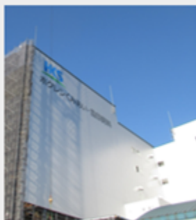
苫小牧の新工場 (2021年10月撮影)
