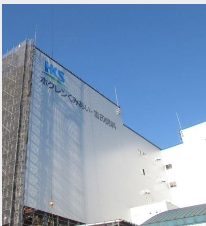
苫小牧の新工場 (2021年10月撮影)
