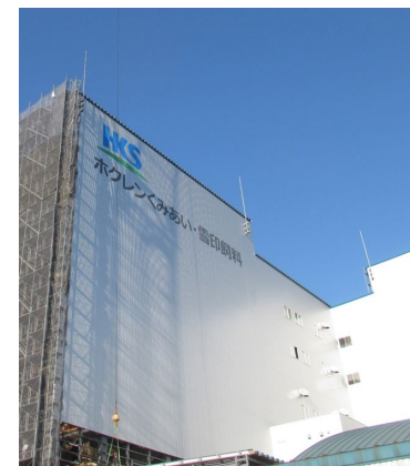
苫小牧の新工場 2021.10月撮影
