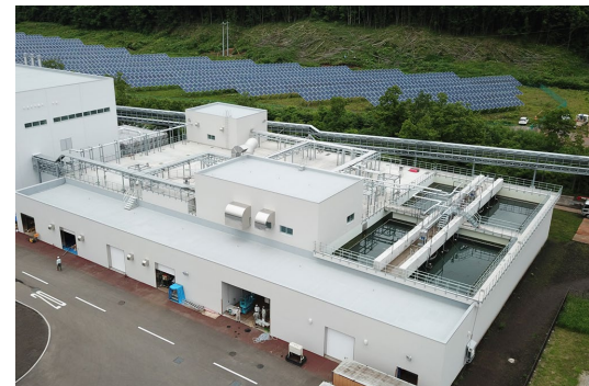
磯分内工場の排水処理設備
