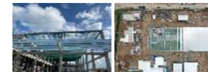
工場建設の様子
