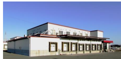
EN Otsuka Pharmaceutical Co., Ltd. (Kitakami Plant)
