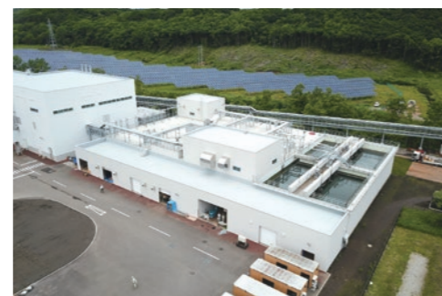
排水処理設備(磯分内工場)
