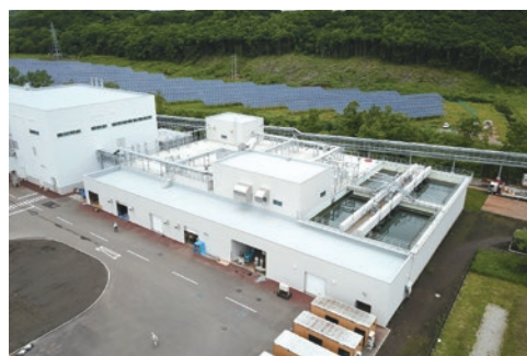
排水処理設備 (磯分内工場)
