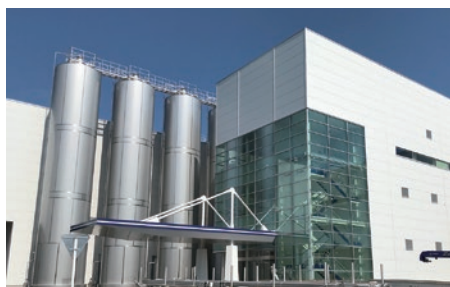
建設中の磯分内工場 (2020年7月現在)
