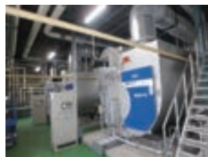
新型炉筒煙管ボイラー
