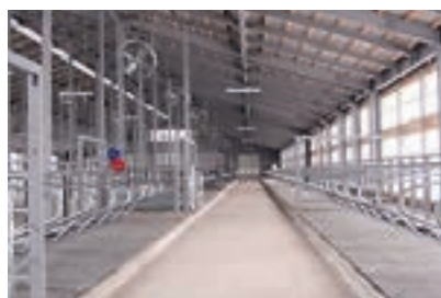
完成した牛舎
