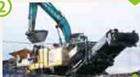
ガラパゴス(コンクリート粉砕機)で粉砕し、
