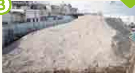
粉砕したコンクリートを新製造棟の砕石として再利用しました。
