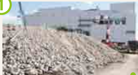
旧製造棟の取り壊しで発生したコンクリート廃材を、
