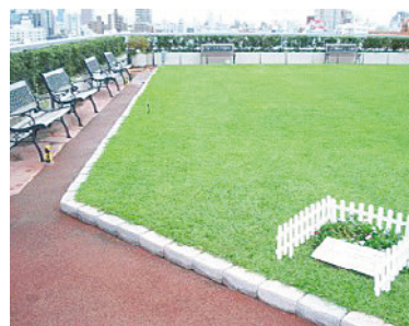
東京本社ビルの屋上緑化
