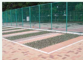
駐車場緑化ブロックシステムの採用
