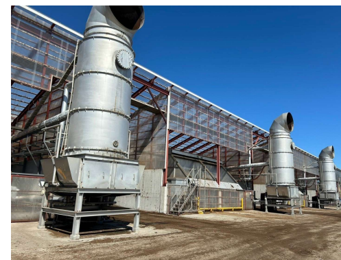
北海道の酪農家におけるふん尿の強制発酵設備 ※メタン等の削減によりクレジット化され、雪印メグミルク(株)で活用
