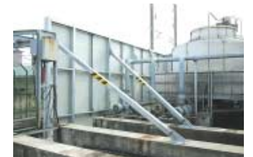
機工棟屋上防音壁(福岡工場)
