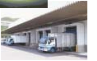
冷気や音が外へ逃げないように冷蔵庫出荷口にドックシェルターを導入
