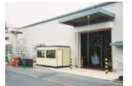
油温減圧乾燥装置と紙パック処理機が設置されているエコセンター
