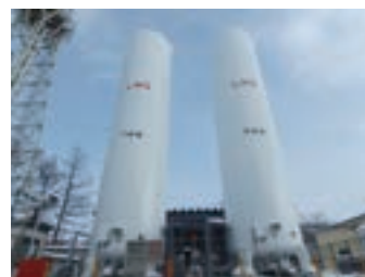
液化天然ガス貯蔵タンク(磯分内工場)
