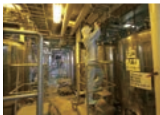
台を設置し、作業の安全性を向上しました。
