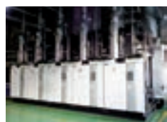
大型貫流ボイラ(5基)
