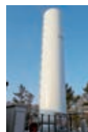
液化天然ガス貯蔵タンク
